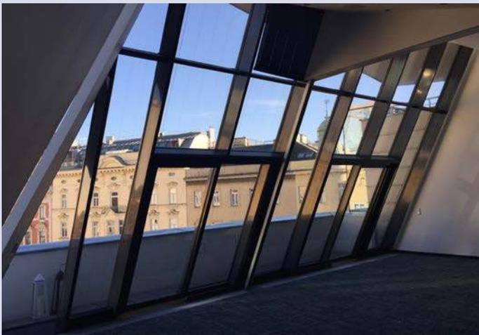
AXAAR® in einer Pfosten-Riegel-Fassade
